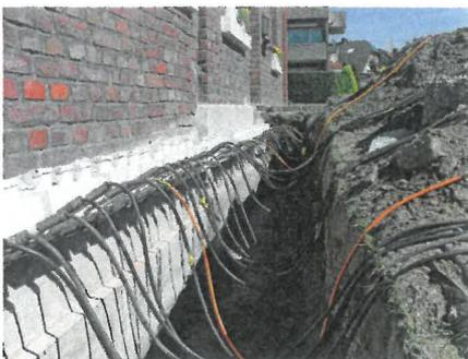
Eine der wirksamsten Schutzmaßnahmen gegen aufsteigende Feuchtigkeit ist eine Horizontalsperre: Dabei wird das Mauerwerk mithilfe von Heizstäben, die in Bohrlöcher in der Wand eingeführt werden, vollständig ausgetrocknet. Anschließend wird Spezialparaffin eingebracht. Isotec
