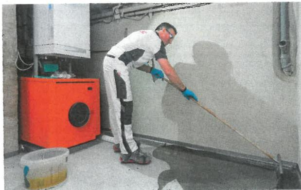
Kellerbodensanierung: Es wird eine spezielle Versiegelung aufgetragen und verteilt. Darauf folgen Haftvermittler und Verlaufs-masse. Letztere bildet im abgebundenen Zustand die Schutz- und Nuttschicht. Isotec
